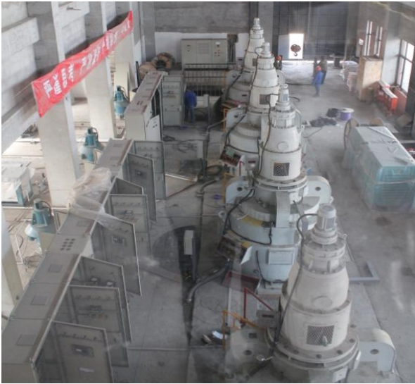
图：密云水库调蓄项目屯佃泵站
